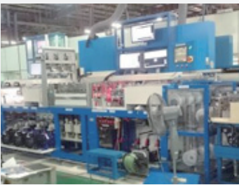
メッキライン改造工事
